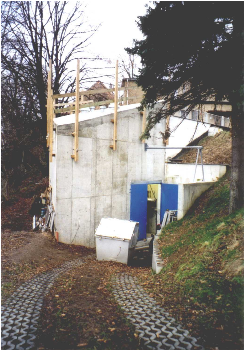
Anbau an die Filterhalle
